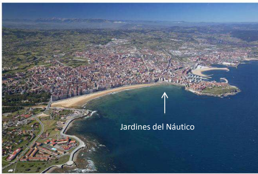
Vista aérea de Gijón.
